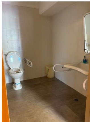
Vista del sanitario para PcD recientemente ejecutado
