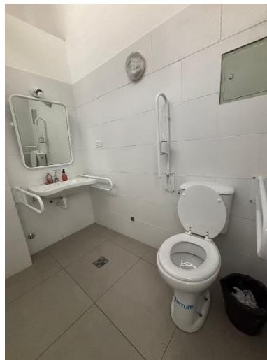
Vista del sanitario para PcD recientemente ejecutado
