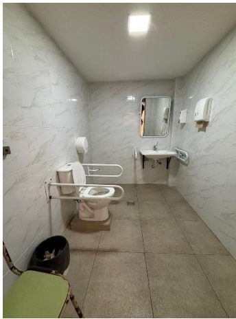
Vista del sanitario para PcD recientemente ejecutado y del sector de los sanitarios de nivel inicial pendiente de ejecución.
