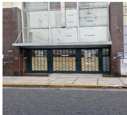
Vista de trabajos de fachada y ejecución de rampa.
