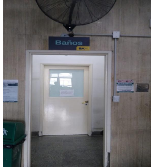
Foto N° 18 Ingreso a sanitarios
