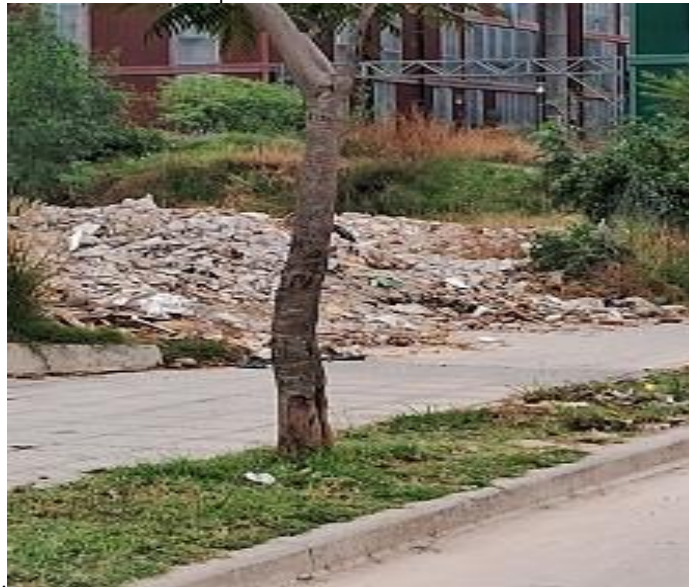
FOTO N° 4 terreno sin cerca perimetral, material de demolición en vereda acumulación de residuos, escombros cercos y estructuras provisionarias Sección 3.05 Cerco de obra
