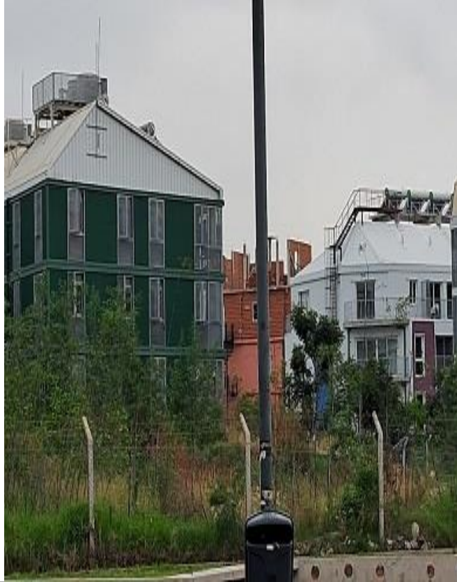
FOTO N° 3: Quedan lotes vacíos para futuras obras, las diferencias entre estructuras edilicias (de color verde anterior, blancas nuevas en YPF Etapa II A-B-C) 27-28 y 29.
