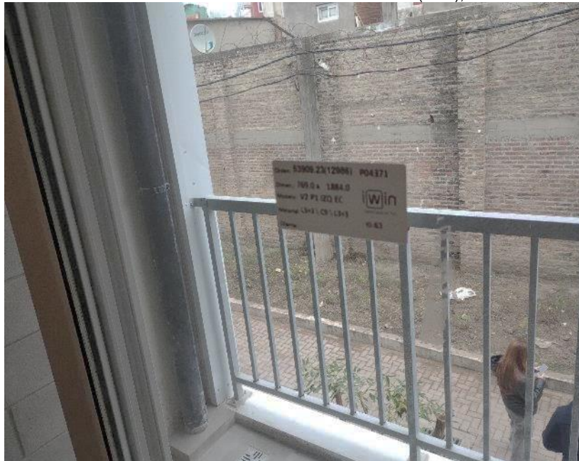
FOTO N° 15 - Ventanales con doble vidrio (DVH),
