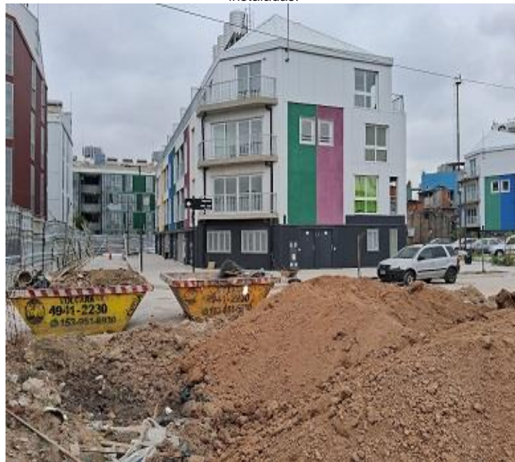
FOTO N° 5 edificio A (27) movimiento de tierra, la zona se encuentra sin apertura de calles, vallas perimetrales instaladas.
