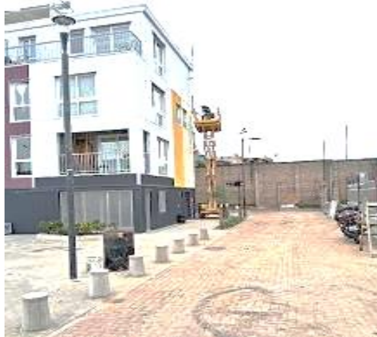
N° 11: Futuro FOTO ingreso al barrio edificio C tareas de terminación con los bolardos de Hormigón.
