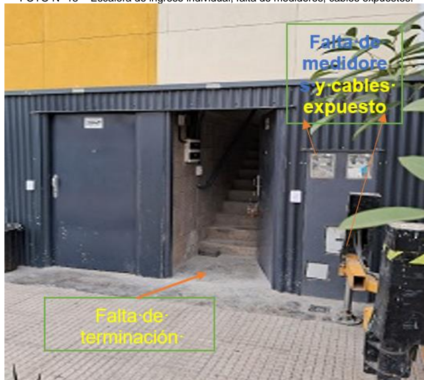
FOTO N° 13 - Escalera de ingreso individual, falta de medidores, cables expuestos.
